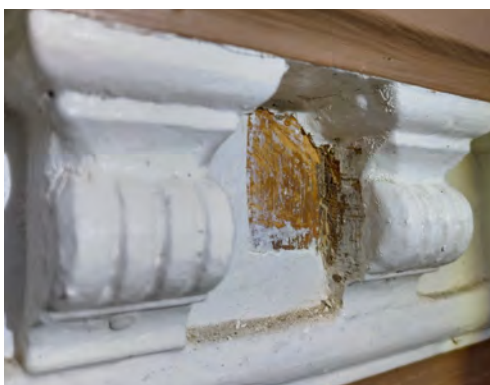
Kuva 5: Ulko-ovien karmin koristelua ja esiinotettua maalipintaa.
