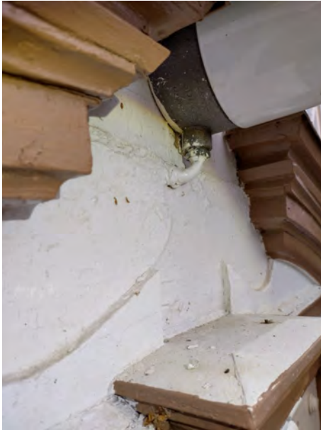
Kuva 7: Ovien päältä on poistettu ristikoristeet.
