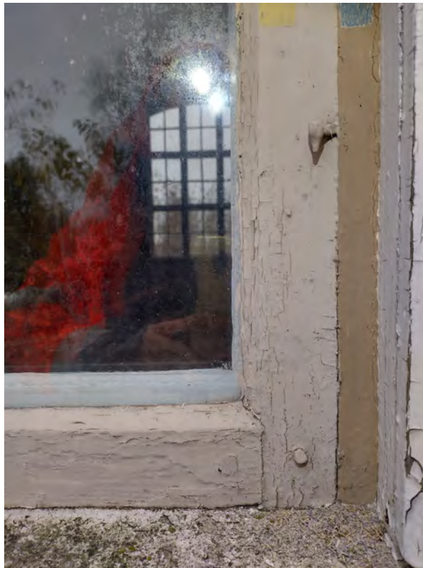
Kuva 2: Urapuiteikkunan kulmaliitos.
