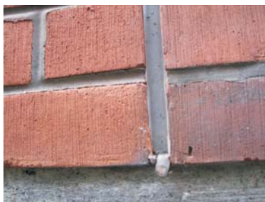
Kuva 4. Esimerkkejä tuuletusputkien ja -koteloiden käytöstä.
