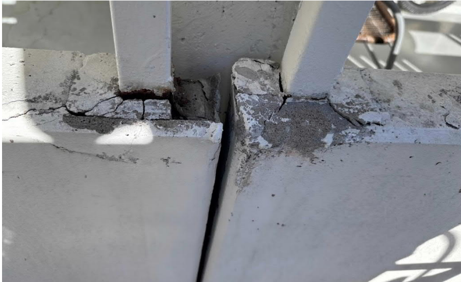
Kuva 1. Esimerkki ruostuneet käsijohteen teräsputken aiheuttamasta betonivauriosta.
