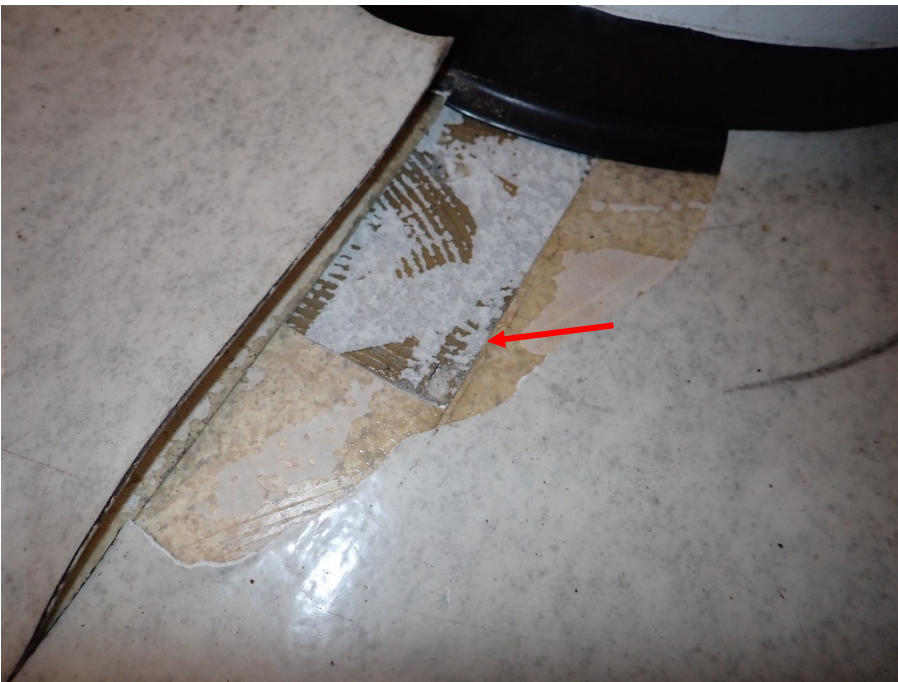
Kuva 3. Näyte 3 aulatilän vanha muovimatto
