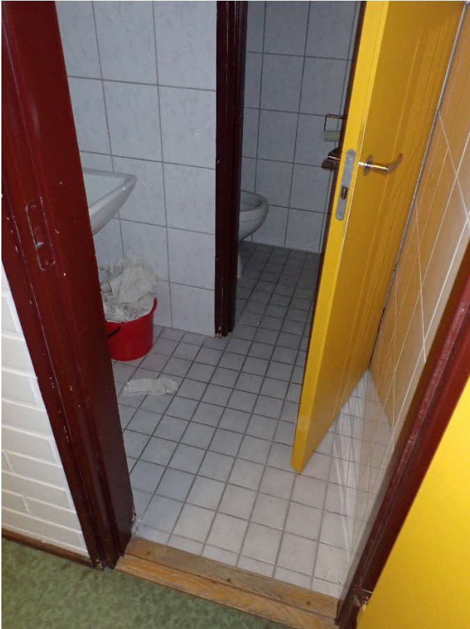
Kuva 4. Näyte 4 wc:n lattialaatoitus, näyte 5 wc:n seinälaatoitus
