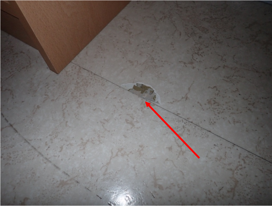
Kuva 2. Näyte 2 toimistohuoneen muovimatto
