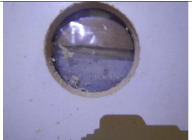
Kuva 3. Rakennuksen runkopuut ovat kyllästettyä puuta.
