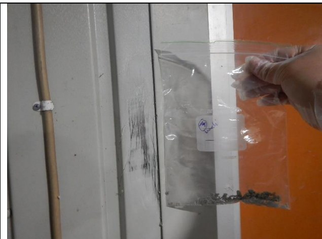
Kuva 6. Sisäseinien ja kattojen pellitysten maali.
