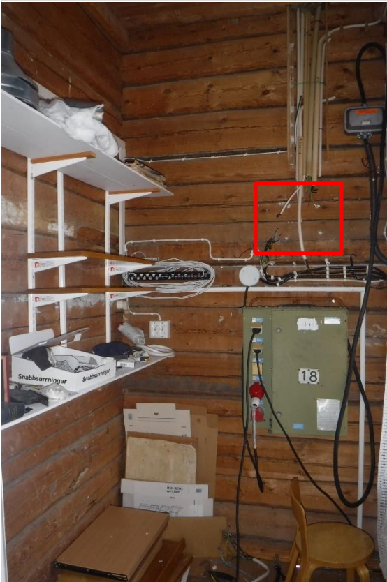
SVK-tilassa asbestipitoisen pahvieristeen jäämiä seinässä.
