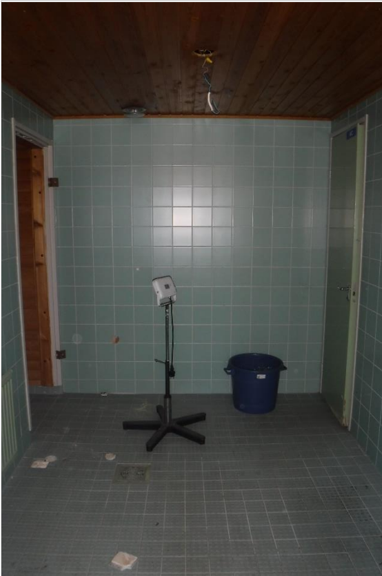
Pesuhuutojen lattia ja seinäpinnoitteet eivät sisällä asbestia.
