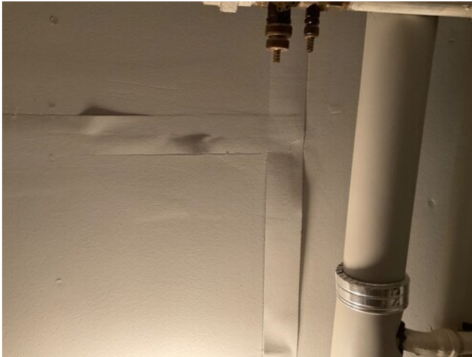
Kuva 1 Seinien ja katon verhouksena on käytetty kipsilevyä.
