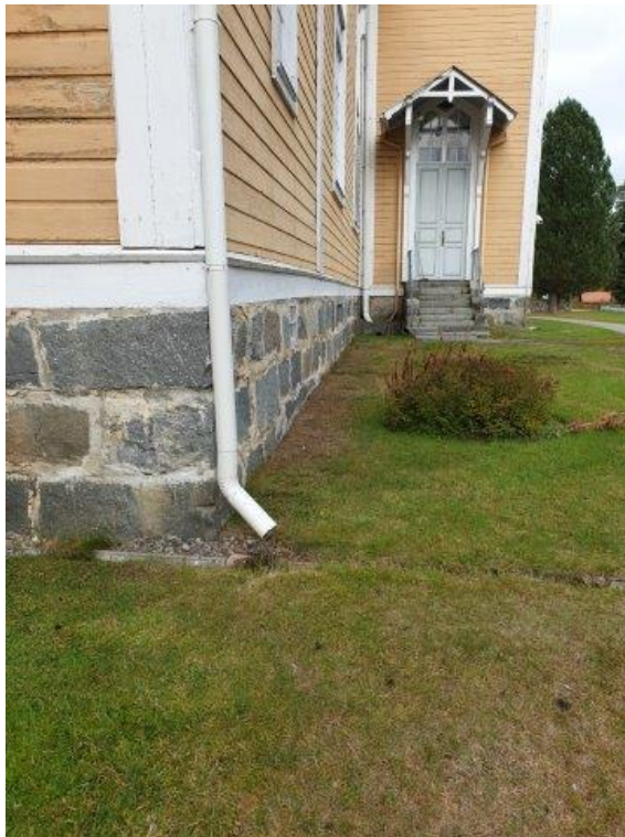
Kuva - Julkisivua länsipuolella
