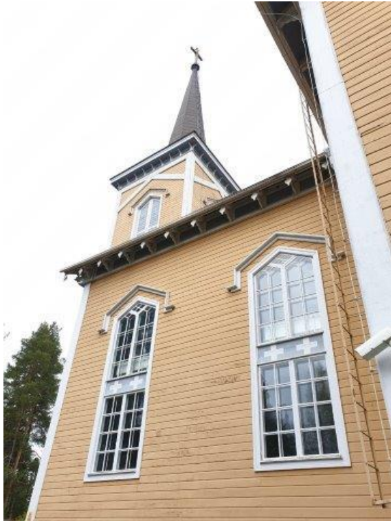
Kuva - Julkisivua itäisivulla
