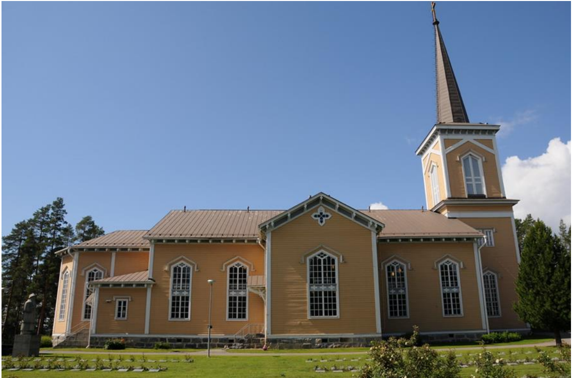
Kuva - Kirkko julkisivu länteen
