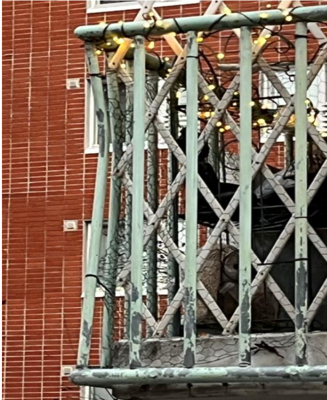
Metallikaiteet maalattu vaalean vihreällä maalilla. Kaiteiden maali sisältää lyijyä ja muita raskasmetalleja.
