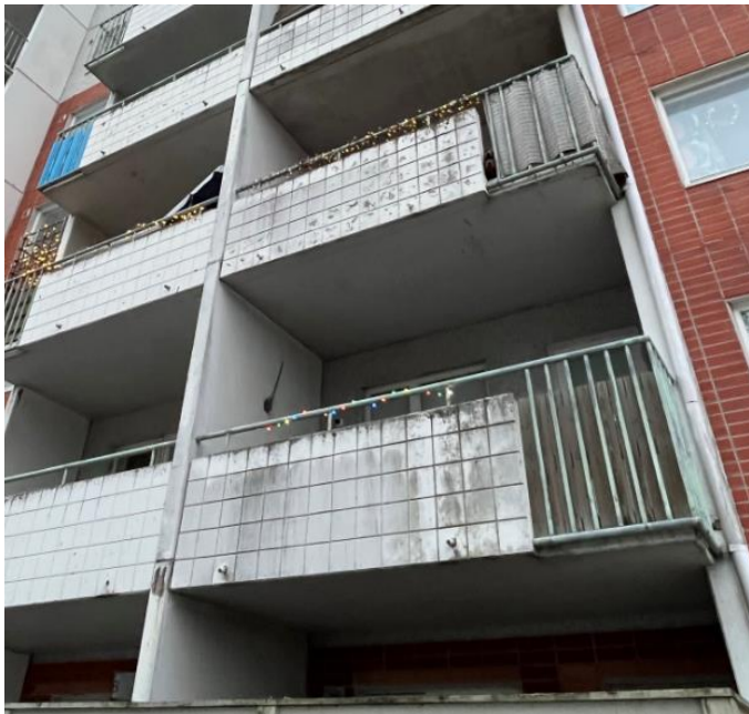
Metallikaiteet maalattu vaalean vihreällä maalilla. Kaiteiden maali sisältää lyijyä ja muita raskasmetalleja.
