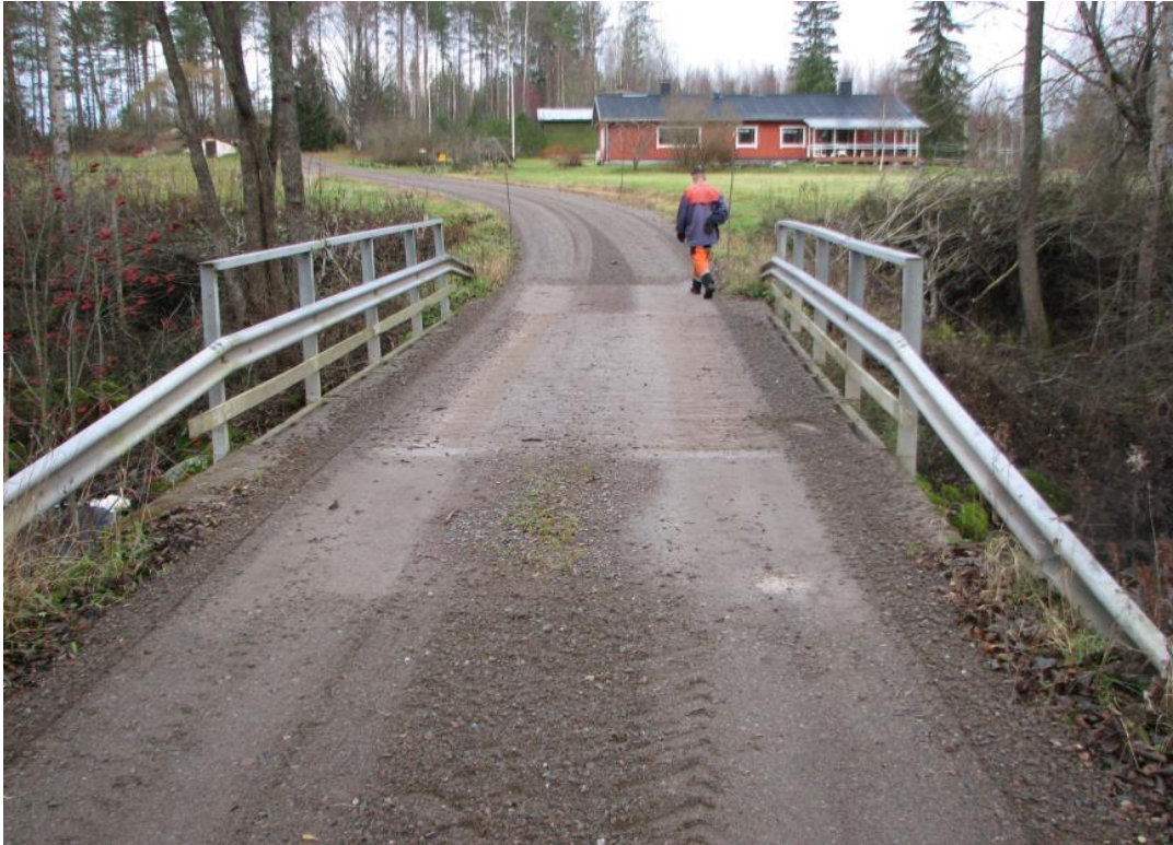
Sillan yleiskuva länteen päin katsottuna.
