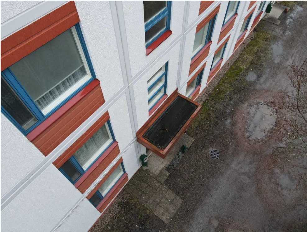
Kuva 3. Sisäänkäyntikatosten kermiä sekä räystäs- ja liittymäpellit uusitaan.
