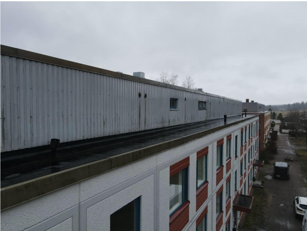
Kuva 2. Yleiskuva ullakkotilan seinästä. Peltiverhous uusitaan, osa alusrakenteista uusitaan.
