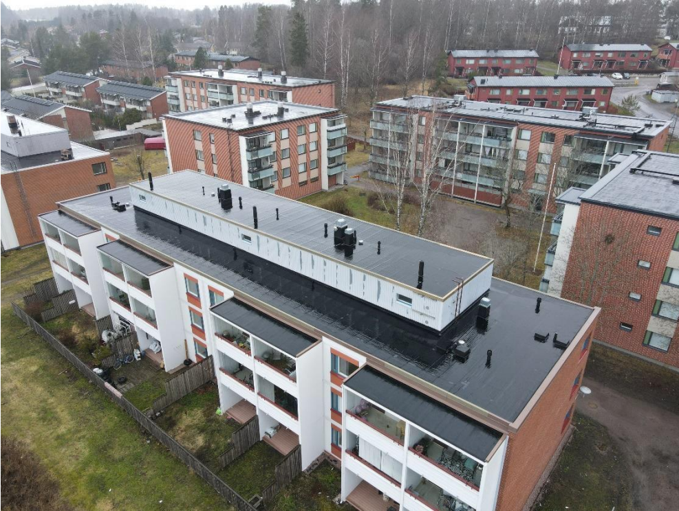
Kuva 1. Yleiskuva. Kaikki rakennuksen kermikatteet uusitaan.
