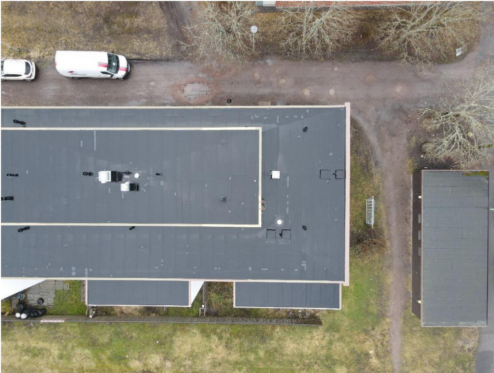
Kuva 5. Oikealla sijaitsevan roskakatoksen vesikate uusitaan urakassa.
