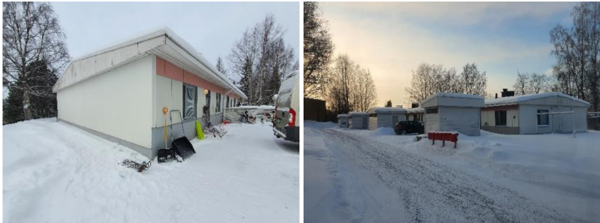
Kuva 2-3. Rakennuksien päätykolmioiden ja- varastojen lujalevytys
