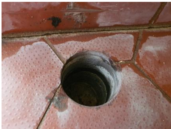
Kuva 9. Klinkkerilaatoitus B-talon yhteisessä pesuhuoneessa.
