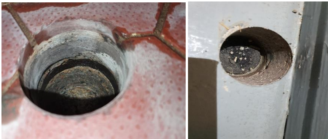
Kuva 4–5. Märkätilan ja- kuivientilojen pikieristeet.
