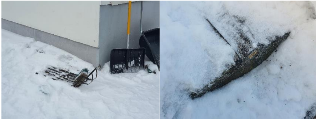
Kuva 18 -19. Sokkelin maali ja -peltikaton maali
