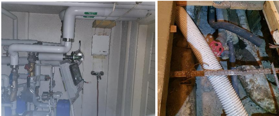
Kuva 20 – 21. Rakennusten putkieristeitä
