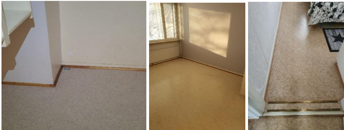
Kuva 6–8. Asuinhuoneistojen erilaisia muovimattoja.
