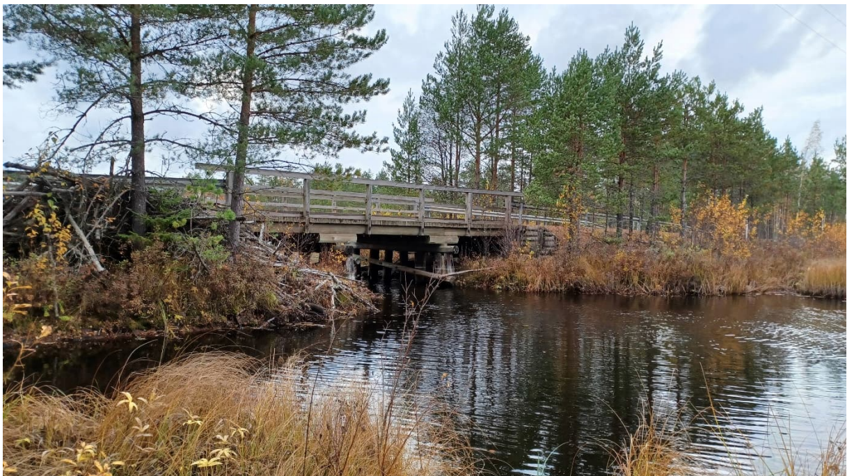
Nykyinen uusittava Hirvenpäänjoen silta.
