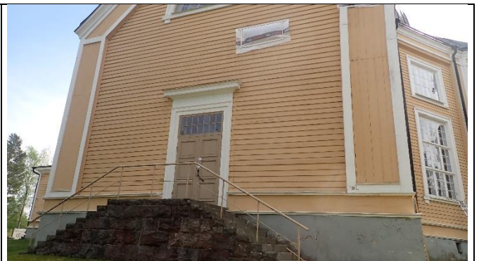
Pohjoisseinää: julkisivun keltainen ja valkoinen maali sekä vesipellin pintaa
