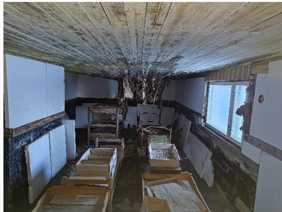
Kuva 5. Päärakennuksen kellarikerroksen perusmuurin ja alapohjan bitumisivelyt eivät sisällä asbestia. Bitumisivelyt sisältävät PAH-yhdisteitä
