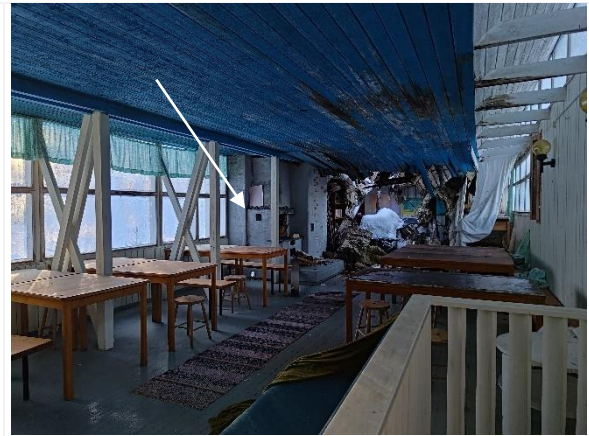
Kuva 4. Päärakennuksen sisäpuolella olevan tulisijan saumalaastit ja muurin pinnoitteet eivät sisällä asbestia.
