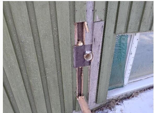
Kuva 6. Päärakennuksen tuulensuojana käytetty bitumipahvi ei sisällä asbestia.
