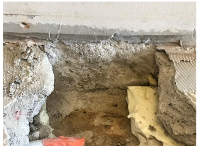
Kuvat 5 a ja b. Kuvassa a rikkiporattu lattialämmitysputki. Rakennuksen väliseinät lähtevät alapohjan pohjabetonilaatan päältä (kuva b), jotka yleensä estävät vaaka-suuntaisen kosteuden kulkeutumisen pohjalaatan päällä.
