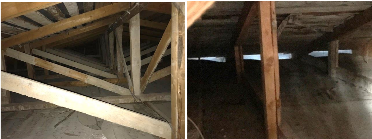
Kuvat 8a ja b. Yleiskuva yläpohjatilasta (vas. kuva). Yläpohja tuulettuu hyvin räystäältä (oik. kuva).
