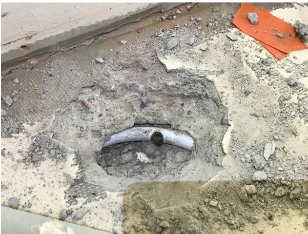
Kuvat 5 a ja b. Kuvassa a rikkiporattu lattialämmitysputki. Rakennuksen väliseinät lähtevät alapohjan pohjabetonilaatan päältä (kuva b), jotka yleensä estävät vaaka-suuntaisen kosteuden kulkeutumisen pohjalaatan päällä.
