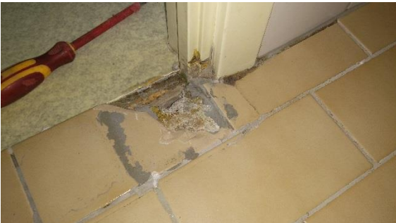
Lattiaklinkkerilaatat, kiinnikkeet, saumat, näyte 3, 16.
