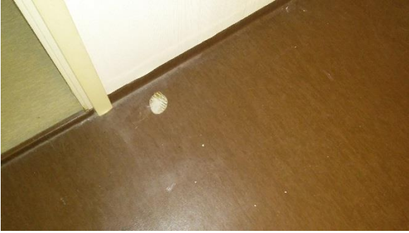
Asuntojen KH lattiamatto, liima, tasoite, näyte 6.
