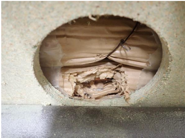
Kuva 7 Keittiön seinärakenteen sisällä on putkissa aaltopahvieriste. Eristeessä ei havaittu asbestia.
