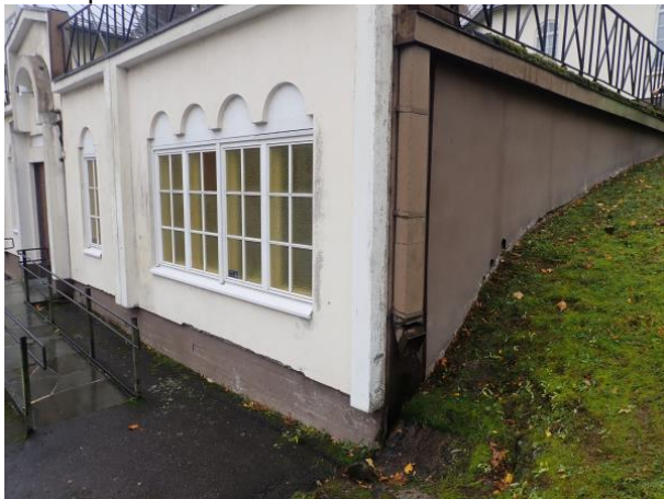
Kuva 9 Ulkoseinässä on maanvastaisilla osuuksilla kermi ja maanpinnan yläpuolella lujalevy. Kermissä ja levyssä ei havaittu asbestia/haitta-aineita.
