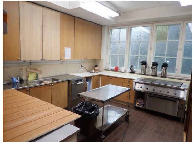
Kuva 2 Keittiön pintamateriaaleissa (lattialaatan laastit, seinän muovitapetti ja liima) ei havaittu asbestia/haitta-aineita.
