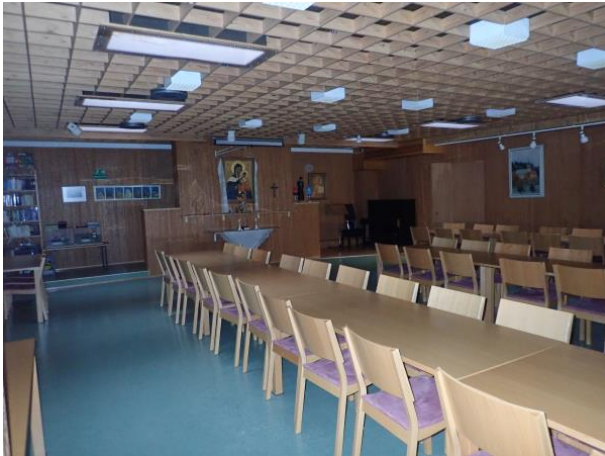
Kuva 1 Seurakuntasalissa on seinissä vaneripaneelit. Lattian vinyylilaatoissa ja liimassa ei havaittu asbestia/haitta-aineita.
