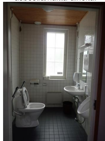
Kuva 4 Wc-tilat on uusittu vuonna 2005 tehdyn peruskorjauksen yhteydessä.
