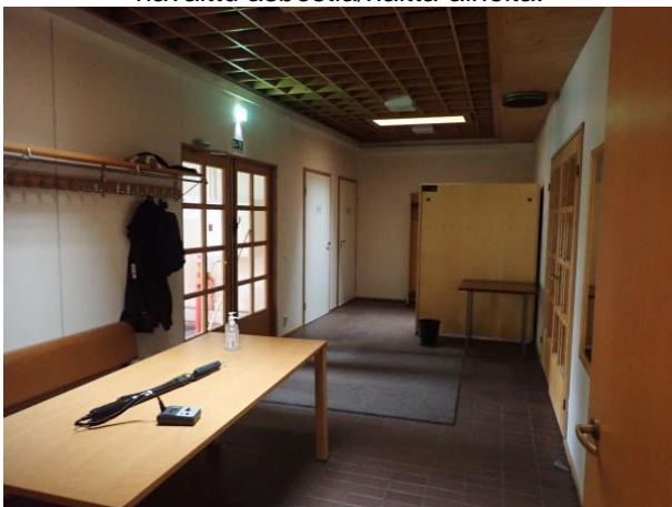
Kuva 3 Eteistilan seinissä on lastulevyt ja lattia on laatoitettu.
